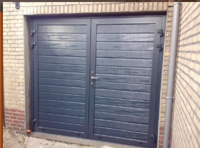
AW40-2 Horizontaal smal geprofileerd, houtnerf structuur, RAL 5011 donkerblauw
